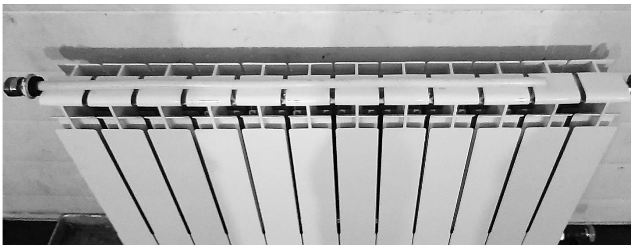
Фото А. Удлинитель потока. Длина трубки L_{уп} = 840 мм, наружный диаметр D_n = 16 мм, внутренний диаметр d_{вн} = 11 мм.
