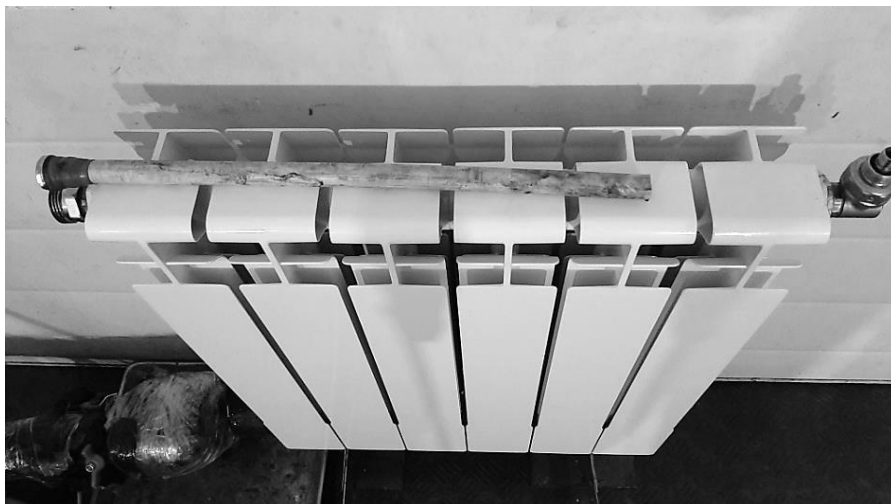
Фото А1. Удлинитель потока. Длина трубки L_{уп} = 360 мм, наружный диаметр D_n = 16 мм, внутренний диаметр d_{вн} = 11 мм.
