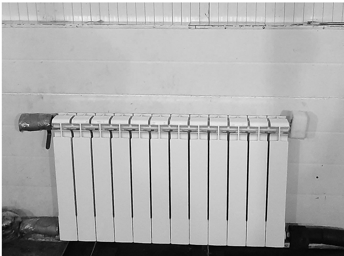
Фото 3. Подключение снизу - вниз.
