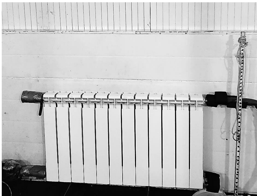
Фото 4. Подключение снизу - вверх по диагонали.
