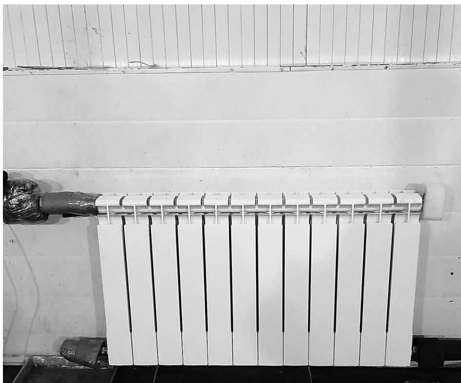
Фото 2. Подключение сверху - вниз по диагонали
